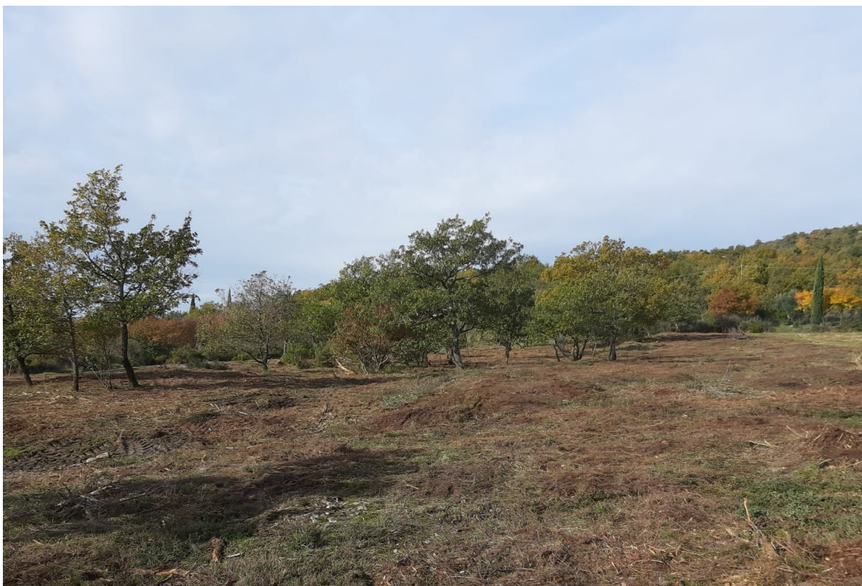
Lavori di realizzazione del viale parafuoco nei pressi di Casamona; sono ben evidenti i residui di Erica scoparia tagliati di recente.
